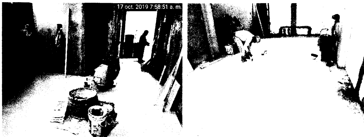
Foto N° 05 y 06: Vista de los Trabajos realizados en area de Administración, colocación de pisos de porcelanato.
