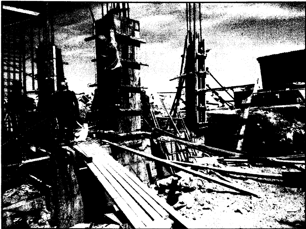
Fig. 02 Habilitación de acero fy=4200 kg/cm 2 y encofrado para columnas del tanque elevado
